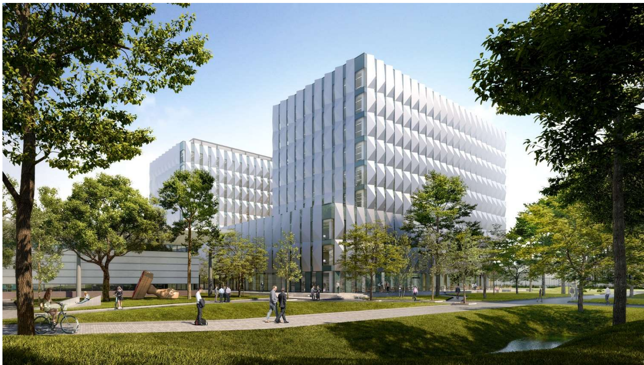
Campuszijde Gebouw 3 – Impressies JHK Architecten / Backbone visuals
